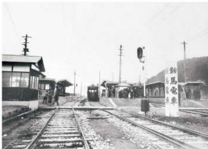
鞍馬電車の山端駅（写真：京都電燈）
