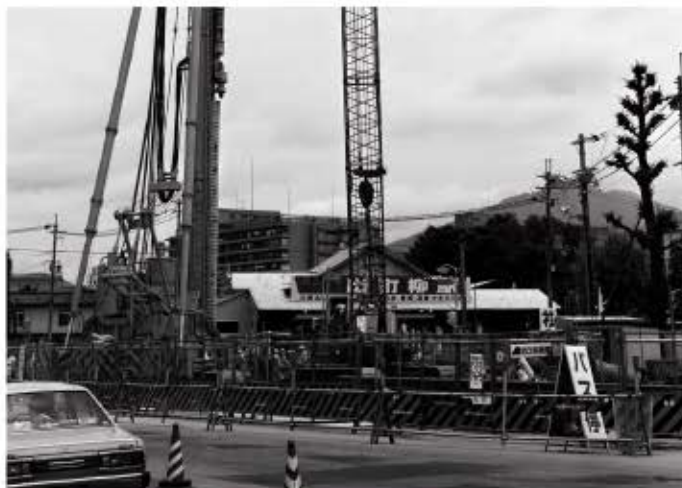
京阪電車の出町柳駅付近の地下駅工事の様子
