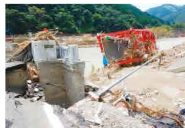
口絵 25 令和 2 年 7 月九州北部豪雨災害 (2020 年): 流出した橋梁 (C13)
